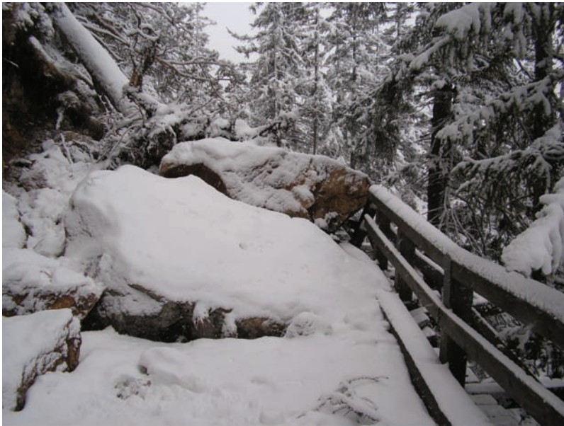
Bild 7: Felssturz in der Weißwand bei Schneizlreuth, Winter 2007/2008
