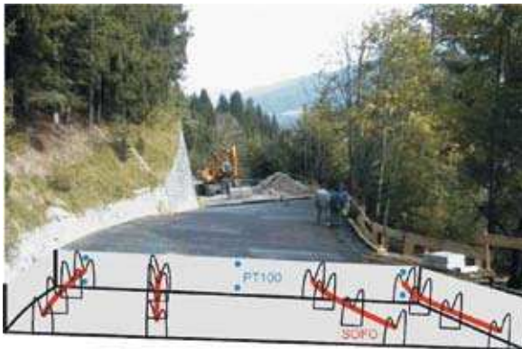
Bild 16: Überwachung einer Hangbrücke mit faseroptischen Sensoren /Brunner, Lienhart/
