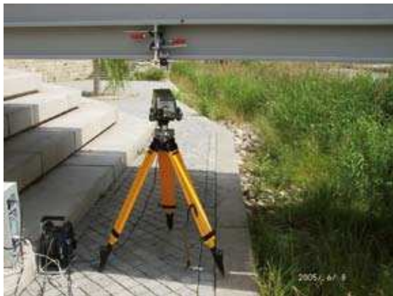
Bild 7: Messaufbau an der Fußgängerbrücke
