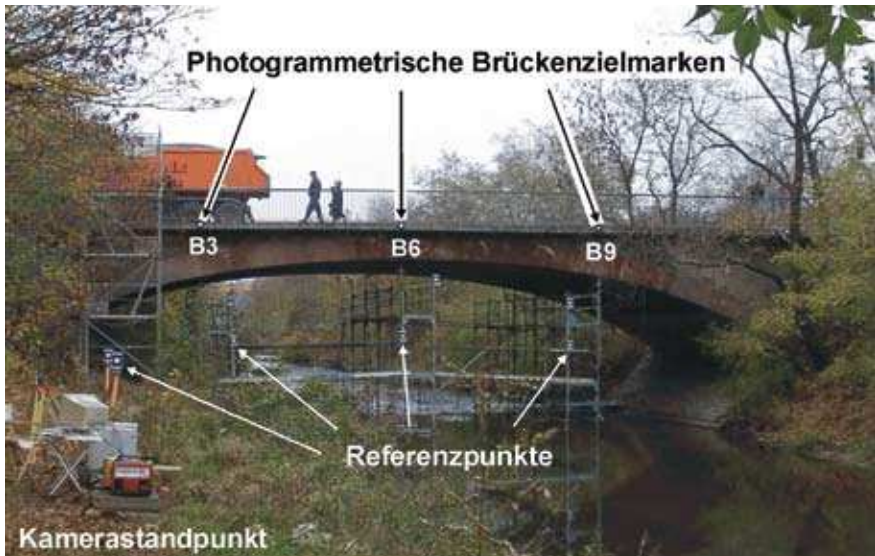
Bild 21: Aufnahmesituation an der Brücke
